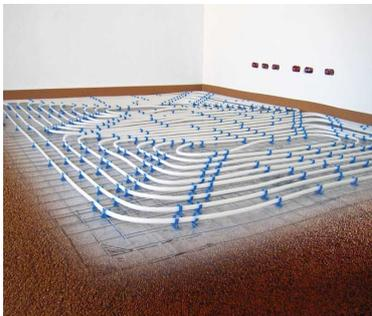
I tubi radianti a pavimento verranno posati su sottofondo da cm. 10/12 di cellulare alleggerito con sovrapposto apposito supporto che consente il fissaggio delle tubazioni.
